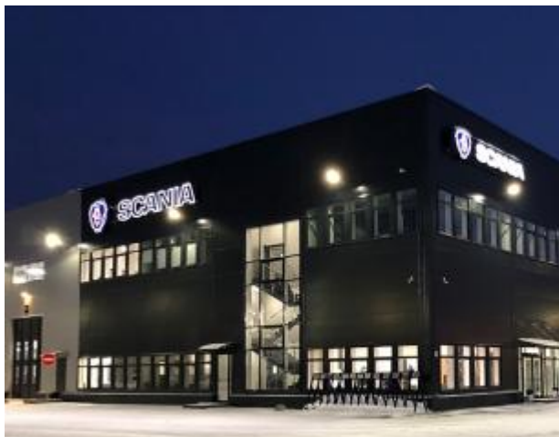
Фото: Освещение станции технического обслуживания SCANIA
